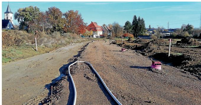
Eingebautes Material im Straßenoberbau. Rechts sind die Straßeneinläufe zu sehen. Der linke Bereich ist noch nicht eingeschottert. Dort werden demnächst die Kabel verlegt.
