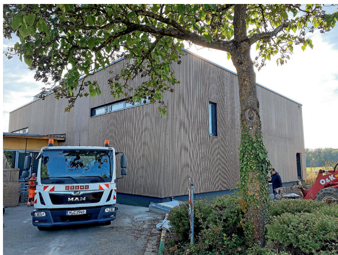
Arbeiten an der Außenanlage
