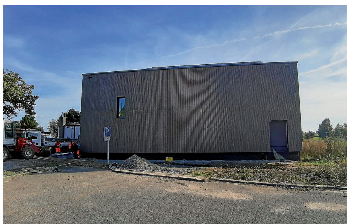
Arbeiten an der Außenanlage
