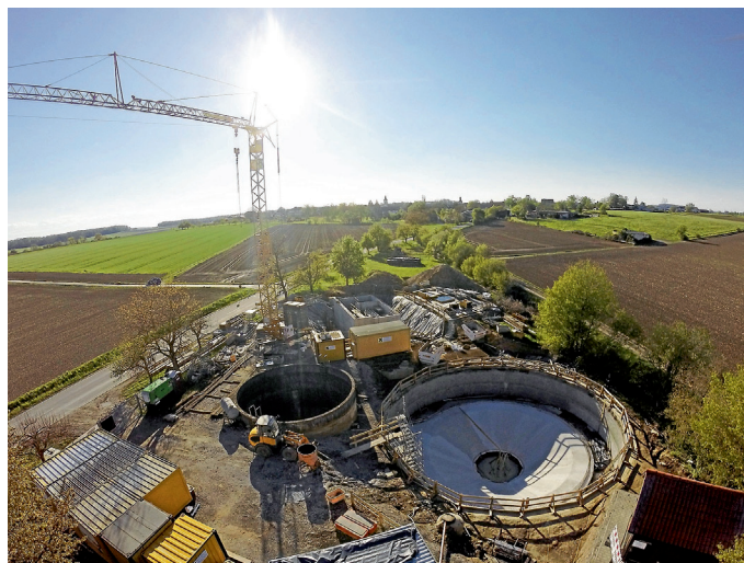
RÜB-Baustelle Mitte Mai
