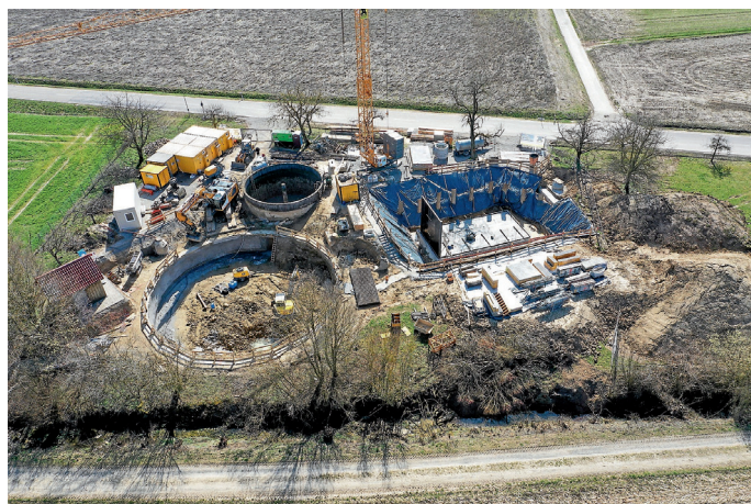
RÜB-Baustelle Ende März
