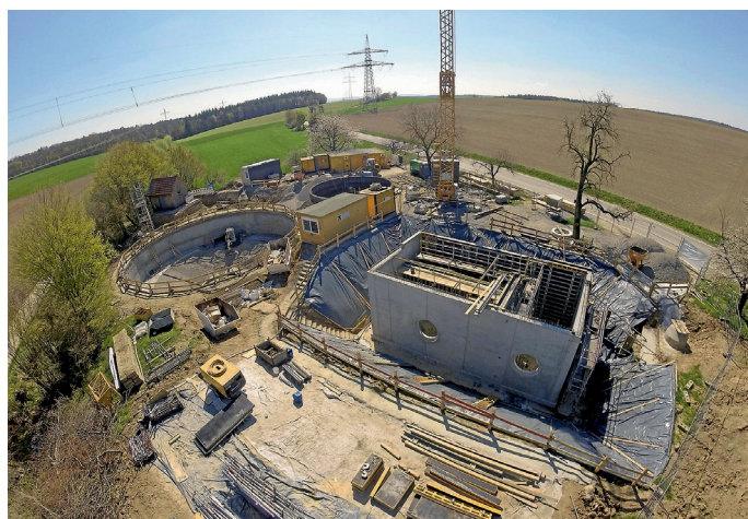
RÜB-Baustelle Ende April
