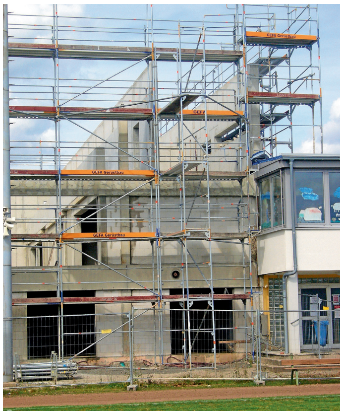
Rohbauarbeiten fertiggestellt Fotos: E. Caspari
