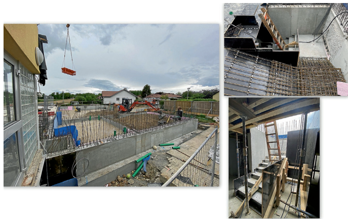
Foto: Neuhäuser Architekten
